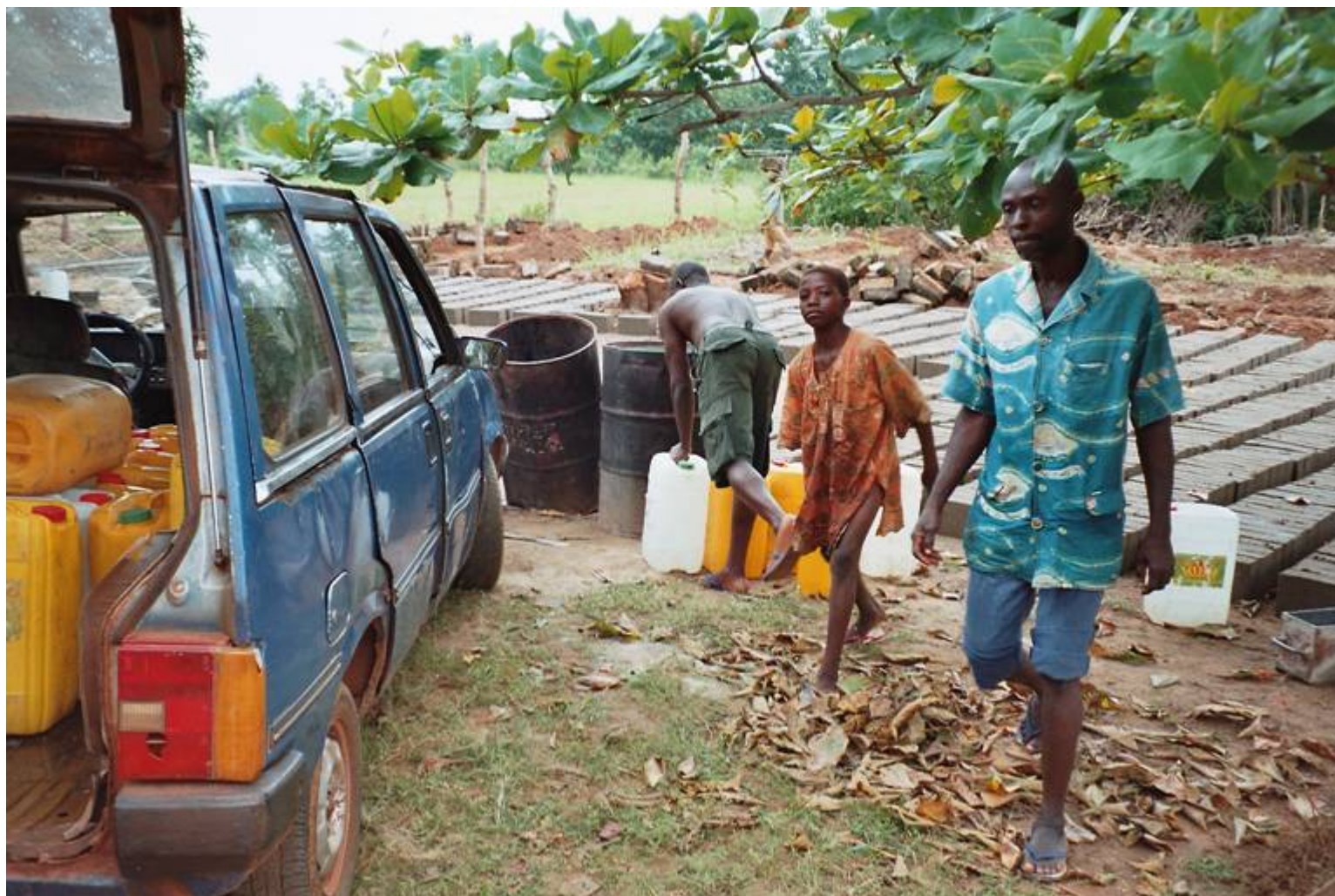
Monsieur Edouard Kpadonou, président de l'APE, en premier plan, qui supervise le chantier et l'avancée des travaux.
